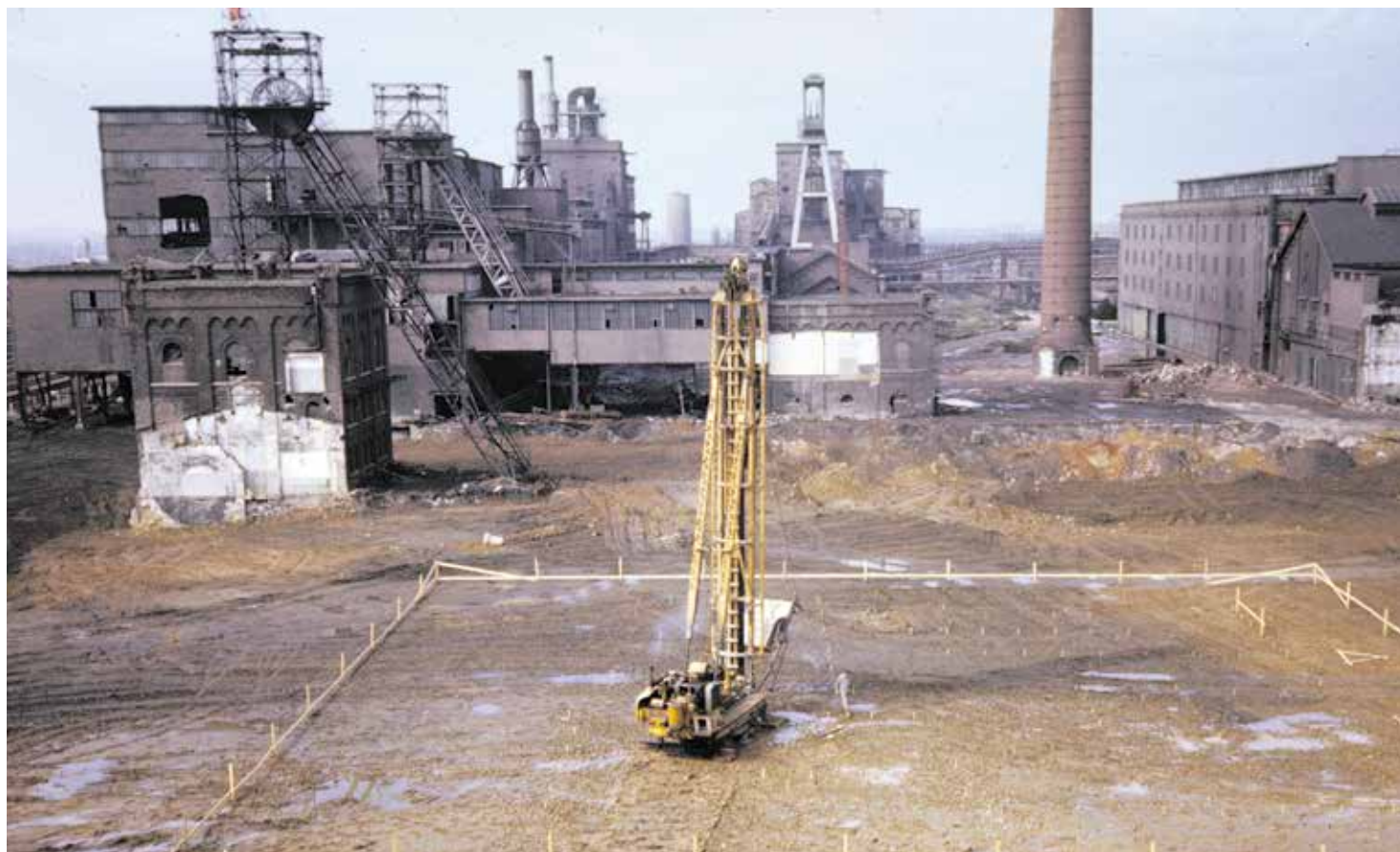
Start van de bouw van het Heerlense kantoor van het Centraal Bureau voor de Statistiek op de plek waar voorheen een deel van de Oranje-Nassauw mijn I lag Foto: J.H.M. Wismans - Historisch Centrum Limburg
